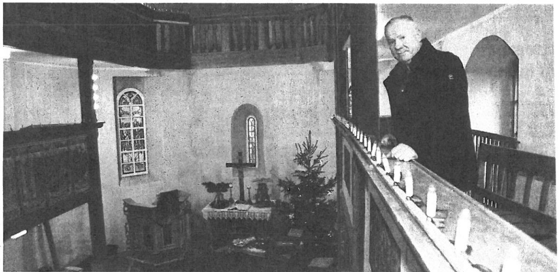
Holger Biehl setzt sich für die Sanierung der Kirche in Unterwirbach ein. Ohne seine Hilfe wäre das Bauwerk wahrscheinlich längst eingestürzt. FOTO: GUIDO BERG
