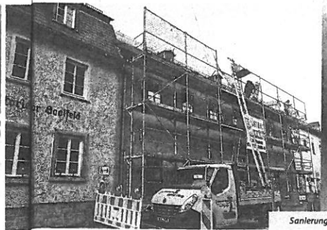
Sanierung des Kirchplatz 3
