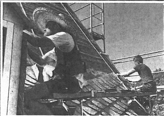
Mitarbeiter der Dachdeckerfirma Scheidig bei der Arbeit an der Kirche in Knobelsdorf.
