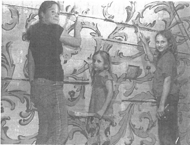
Magdalena, Elisabeth und Victoria schwingen auf dem Gerüst an den Wänden der Decke locker ihre Pinsel. Viel Herzblut und viel Fleiß, so kommt die Sanierung der Kirche voran.
