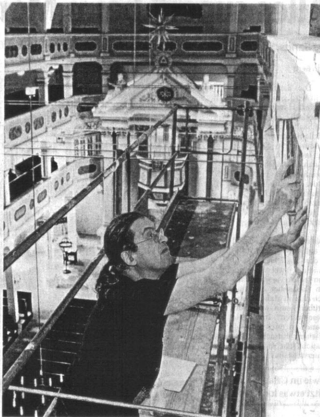
Hartmut Schmeling von der Firma Doreko arbeitet an den Brüstungen der Emporen in der auch „Südthüringer Dom“ genannten Hoffnungskirche in Oberweißbach.
