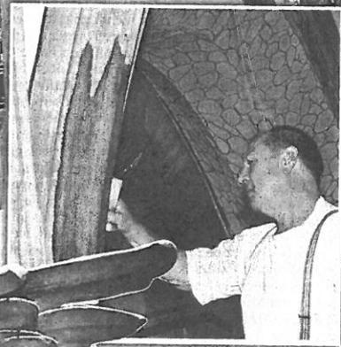
Gewölberippen sind Werksteinarbeiten erforderlich. Das Deckengewölbe weist vielfach größere und kleinere Risse auf. Hier sind umfangreiche Putzarbeiten vonnöten. Abschließend sind Malerarbeiten notwendig, die das Gewölbe in neuem Glanz erstrahlen lassen.
