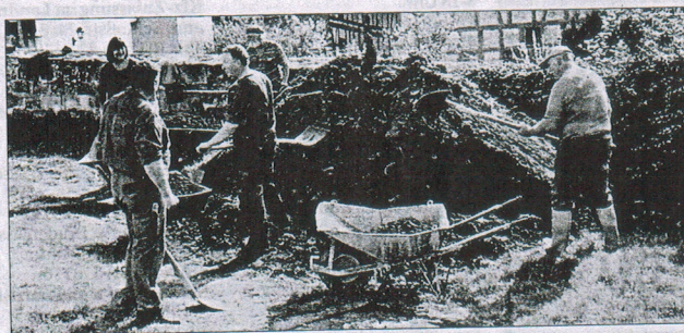
Um das Gelände an der Kirche neu zu gestalten, wurde ordentlich zugapackt.
