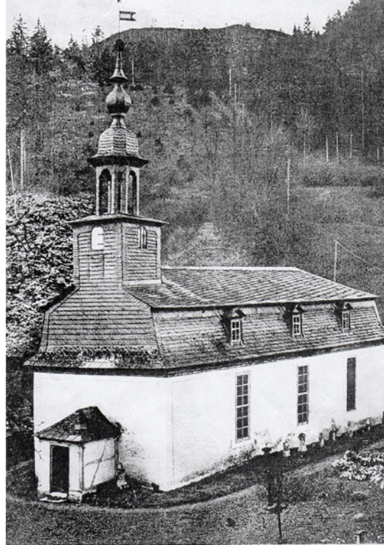
Dorfkirche in Reichenbach bei Probstzella Schieferdach laut Urkunden und amtlichem Zeugnis im Jahre 1809 gedeckt, seitdem nicht umgedeckt, und heute noch in allen Teilen, auch in Farbe, gut erhalten. Schieferwerke Ausdauer A.-G., Probstzella i. Thür. (Abbildung aus: Feitz, Schieferbedachung, Verlag Hermann & Co., Leipzig)
