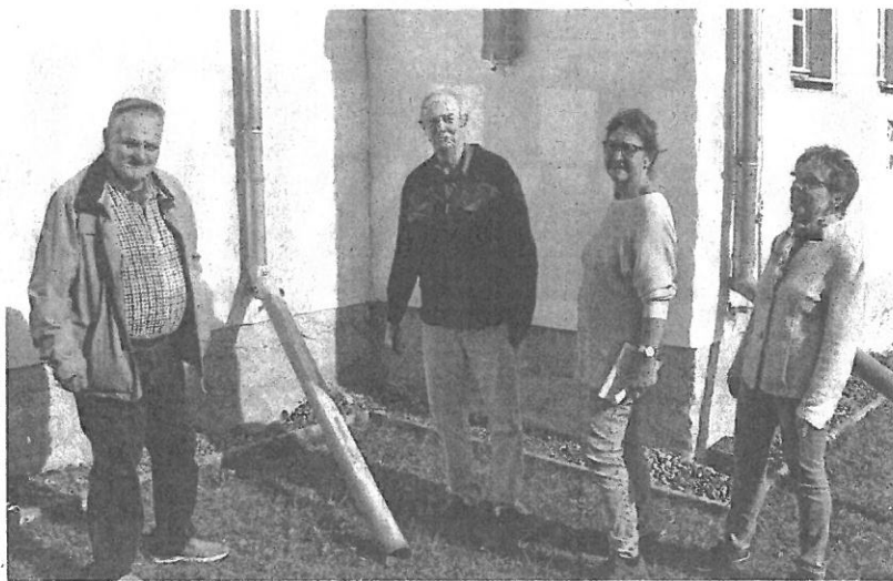
Der Wiederaufbau der Kirche in Volkstedt nach dem Brand kurz vor Weihnachten geht voran. Aber es tauchen neue Sorgen auf. Der Vorsitzende des Gemeindegemeinderates Reinhold Clement und die engagierten Helfer Gerd Röhner, Regina Meier und Heidi Neckermann stehen vor der auf Grund von Wassereintritt beschädigten Kirchenwand.
