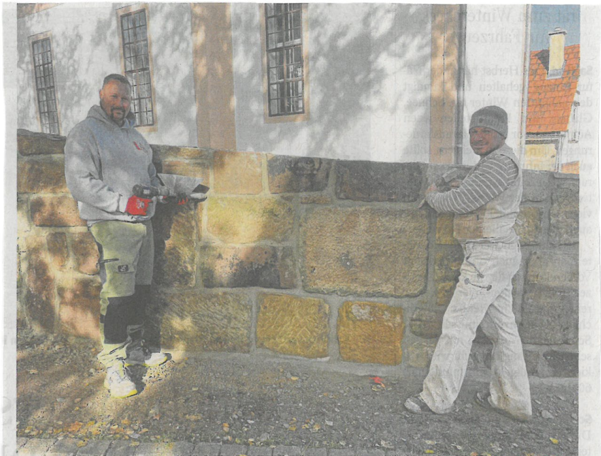
Lars (links) und Marcel Lapinski von der gleichnamigen Steinmetz- & Steinbildhauer-Firma aus Ranis sind zurzeit mit dem Ersatzneubau der Kirchenmauer in Partschfeld bei Uhlstädt befasst. Vor drei Wochen wurde begonnen, ein etwa 15 Meter langes Stück der alten Mauer abzutragen und neu zu errichten. Bis zum Beginn der Kirmes am Freitag soll alles fertig sein.
