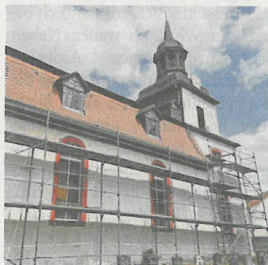
Die Kirche in Neusitz ist derzeit eingerüstet.
