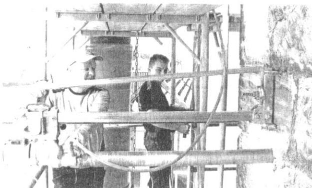
Roland Goy (links) und Jan Dümmler sind für die Sicherung des Turmes zuständig. Damit sich der vorhandene Riss nicht vergrößert, werden Stahlanker eingebaut.
