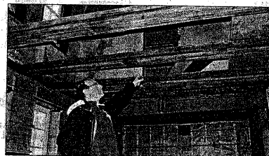
Bauleiter Frank Lindig zeigt auf die Stelle, an der die Originaldecke aus dem 17. Jahrhundert wieder eingebaut werden soll.
