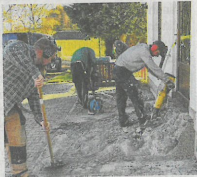
Die Erbau-Mitarbeiter bei der Arbeit.
