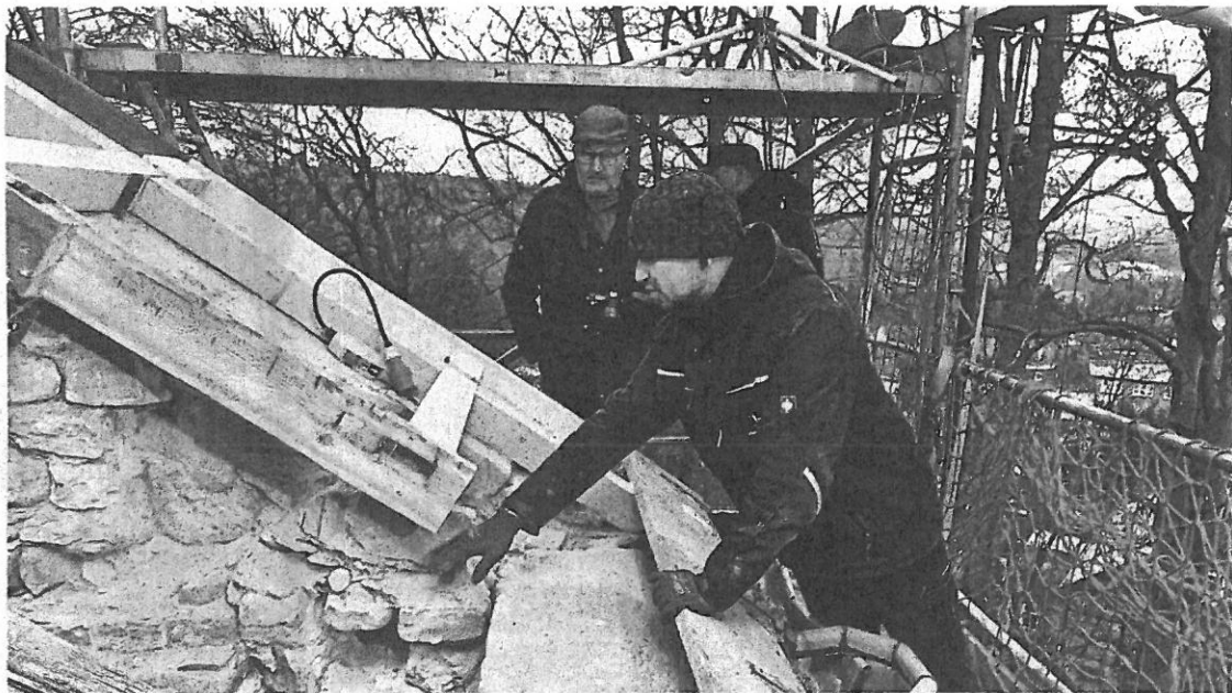
Baubesprechung auf dem Gerüst, oberhalb der Dachrinne: Bernd Stiller, Bauleiter Heiko Hoffmann und Vorarbeiter Christof.
