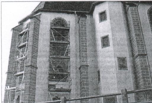
Mitarbeiter einer Dresdner Firma bauen die Fenster an der Stadtkirche nach der Reinigung und Restaurierung wieder ein.
