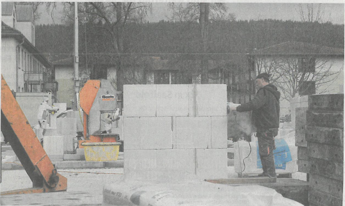
Baufortschritt ist sichtbar an der künftigen Bethanien-Residenz im Rudolspark in Rudolstadt.
