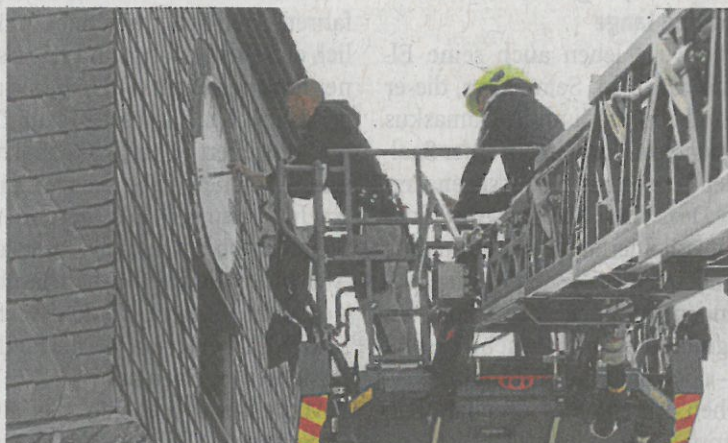
Marcel Klein, Stadtbrandmeister von Königsee, und Ronny Hoffmann, Mitarbeiter der Firma Glocken und Turmuhren Christian Beck aus Kölleda, montieren von der Drehleiter aus das Ziffernblatt und die Zeiger wieder an das Uhrwerk.
