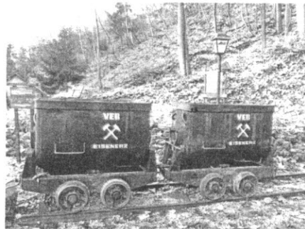
Mit solchen Hunten wurde bis Anfang der 70er Jahre Eisenerz im Ort befördert.
