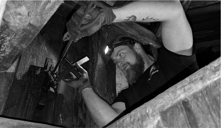
Kevin Lips von Turmuhren & Glocken Willing sorgte mit der Reparatur der elektromechanischen Steuerung dafür, dass es nun wieder eine korrekte Zeitanzeige am Turm der Kirche Unterloquitz gibt. Am Kirchturm in Unterloquitz sind zwei Zifferblätter angebracht. Die Zeiger der beiden mussten synchronisiert werden, damit sie gleich laufen. Mit dem alten Gestänge war das gar nicht so einfach.
