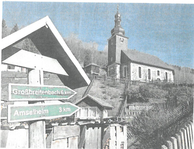
250 Jahre steht das Wahrzeichen des Ortsteiles Oelze am Hang des Kirchbergs. Als Geburtstagsgeschenk soll das Gotteshaus in diesem Jahr eine neue Dacheindeckung bekommen, plant die Kirchgemeinde.
