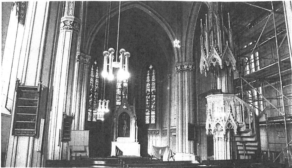
Noch steht im südöstlichen Seitenschiff ein Baugerüst. Es soll heute abgebaut werden, damit in Königsee Ostern in der Stadtkirche gefeiert werden kann, wenn am Samstag genügend Leute zum Putzen kommen. FOTO: HENRY TREFZ
